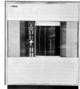
IBM 1405 Höhe 220 cm Breite 197 cm, Tiefe 84 cm Gewicht 920 kg
